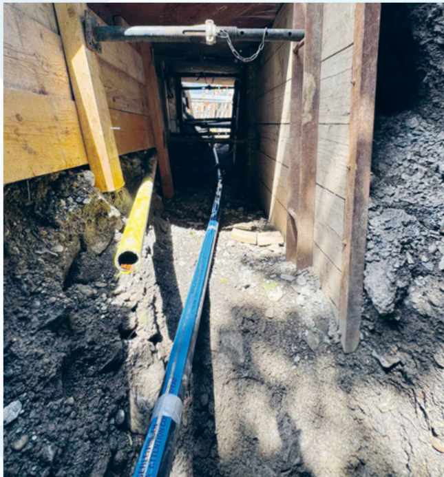
Während des Umbaus des BLS-Bahnhofs wurde die Werkleitungsinfrastruktur erneuert.
