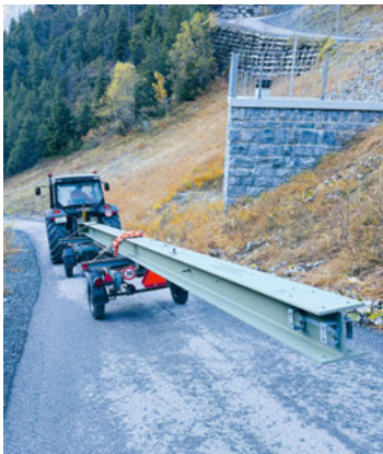
Rückbau nicht benötigter Infrastruktur wie des 16-kV-Mastes Birrelift.
