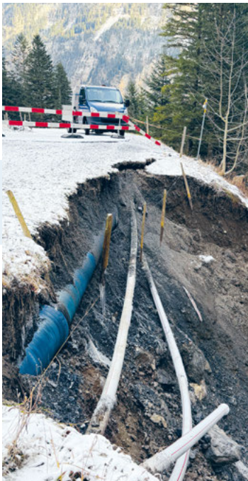
Druckleitungsbruch KKA 19. November 2025: Das Ereignis wurde mutmasslich durch einen Hangrutsch und eine darauf folgende Belastung der Druckleitung ausgelöst. Die Leitung wird neu in einen rund 20 Meter langen Betonriegel eingelegt, welcher im Hang verankert wird. Bauarbeiten im April 2026 abgeschlossen.
