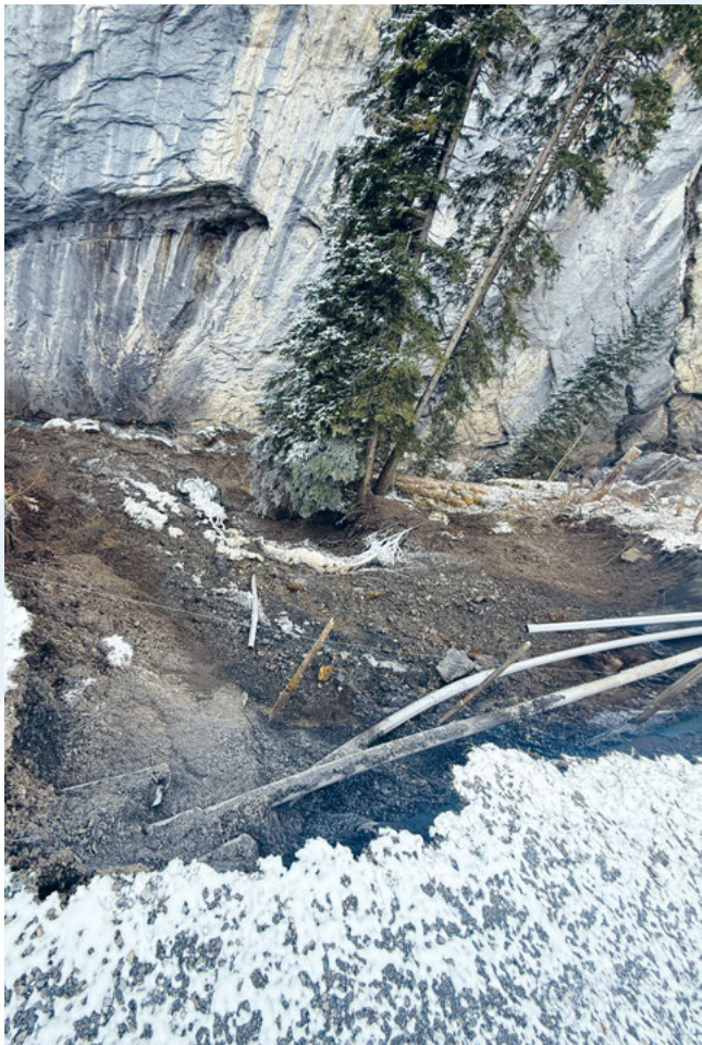
Druckleitungsbruch KKA 19. November 2025: Das Ereignis wurde mutmasslich durch einen Hangrutsch und eine darauf folgende Belastung der Druckleitung ausgelöst. Die Leitung wird neu in einen rund 20 Meter langen Betonriegel eingelegt, welcher im Hang verankert wird. Bauarbeiten im April 2026 abgeschlossen.
